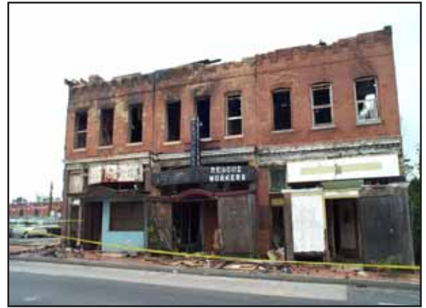
1909-1913 Martin Luther King Jr. Avenue, SE
